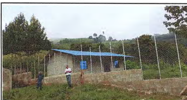
Foto 6: Instalacion de malla para el muro perimetral
