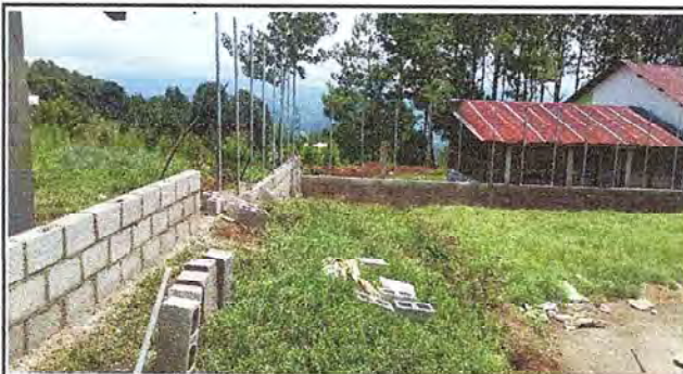
Foto 3: Vista del 40% de avance de muro perimetral
