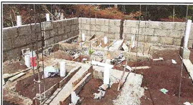
Foto 3: Otra vista de la instalacion de baños
