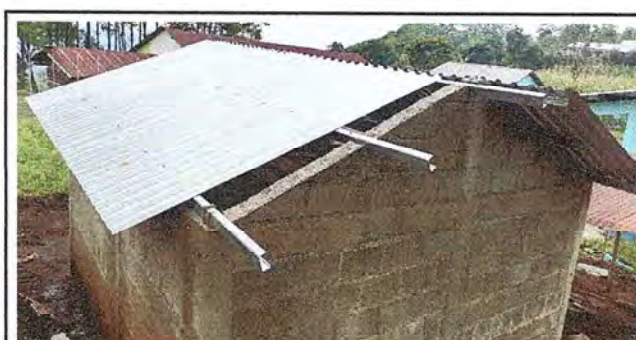
Foto 6: Colocación de techado de baño
