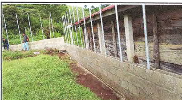
Foto 4: Otra vista de como va el avance del muro perimetral
