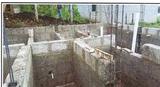
Foto 4: vista del 50%, avance del trabajo de baños
