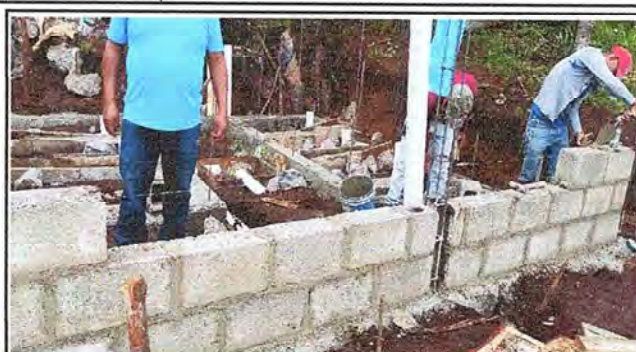
Foto 2: Vista de como va el avance de la instalacion de baños
