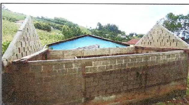
Foto 4: Vista de cocina con un avance del 50% de remodelación
