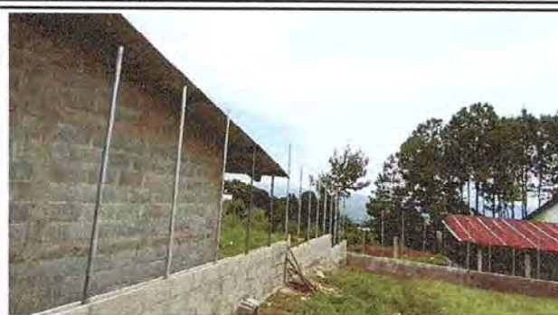
Foto 2: Otra vista del muro perimetral en proceso de sustitución
