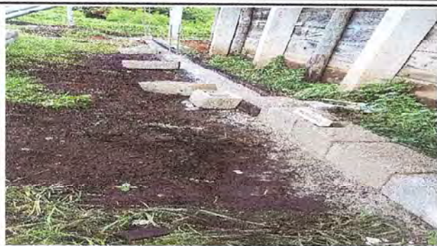
Foto 1: Así se empezó la sustitución de muro perimetral
