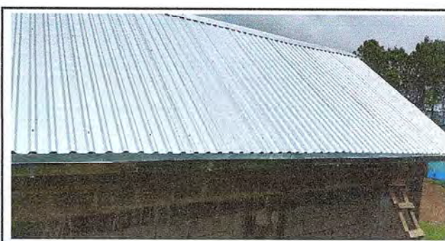
Foto 6: Colocación de techado de cocina
