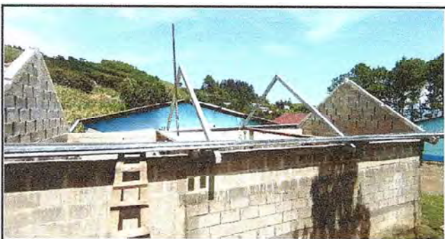
Foto 5: Instalación y colocación de estructuras metálicas de cocina
