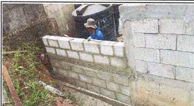
Foto 1: Vista en la parte posterior de cocina, en proceso de remodelación
