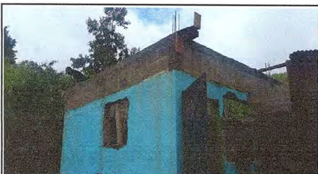
Foto 3: Vista lateral de cocina en proceso de remodelación
