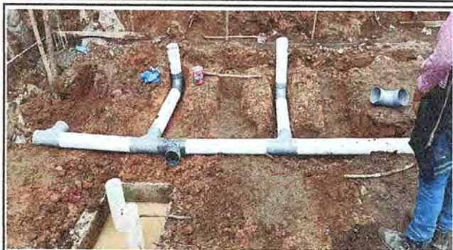
Foto 1: Reparación de drenaje e instalacion de tuberías
